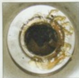
11 Les bagues ont été changées pour éliminer le jeu. Un reste de graisse avant d'introduire l'arbre d'entraînement...
